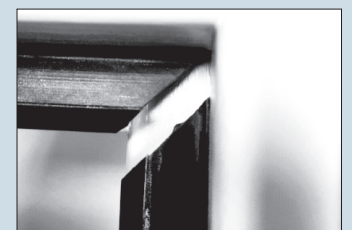
Dichtungsmontage Rahmenstock: falsch ✗
