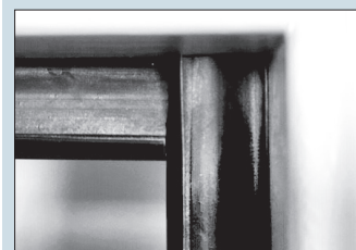
Dichtungsmontage Rahmenstock: falsch ✗
