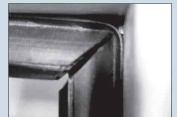
Dichtungsmontage Rahmenstock: falsch ✗
