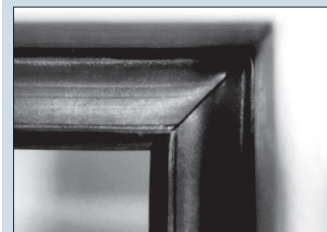
Dichtungsmontage Rahmenstock: richtig ✓
